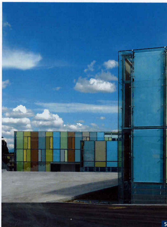
1 Bâtiment Ecole et entrée principale.
