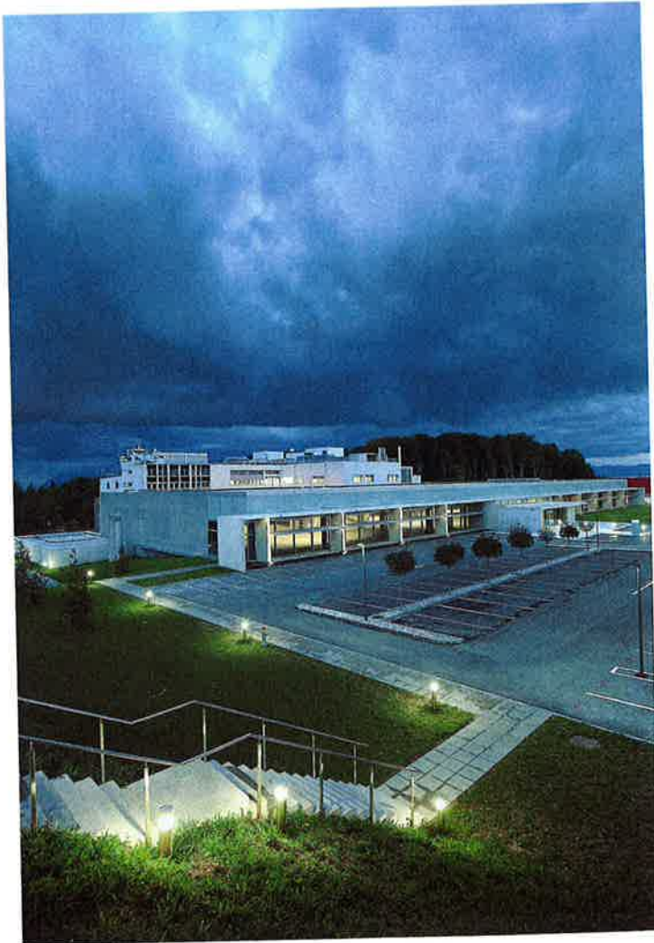
Depuis la route, la nouvelle extension masque un ancien bâtiment à l'allure austère.
