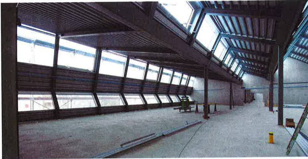
La toiture en sheds donne aux ateliers qui sont placés au dernier niveau une lumière naturelle d'une qualité exceptionnelle.
