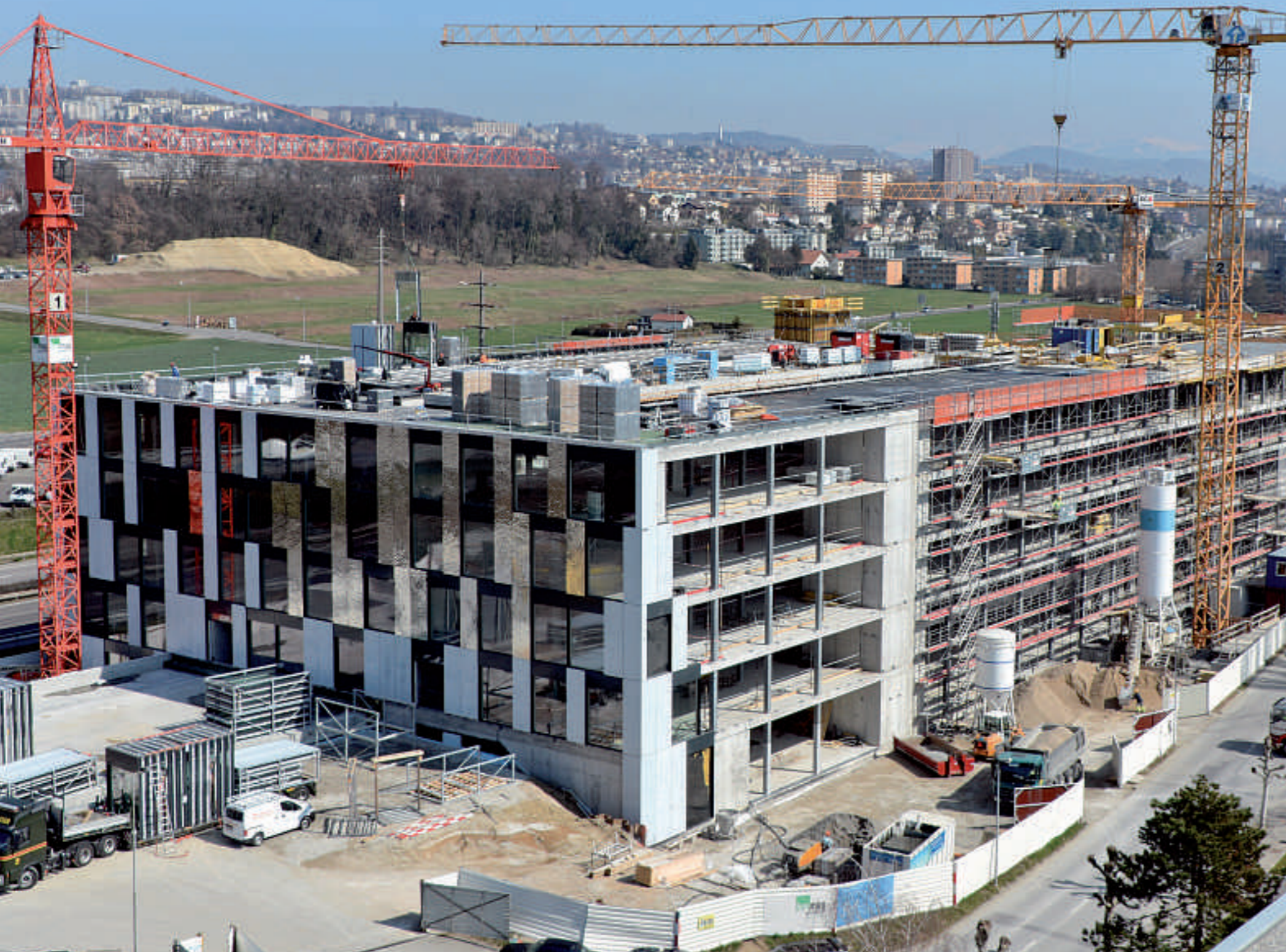
Pose des façades vitrées sur le côté Ouest en mars 2011.
