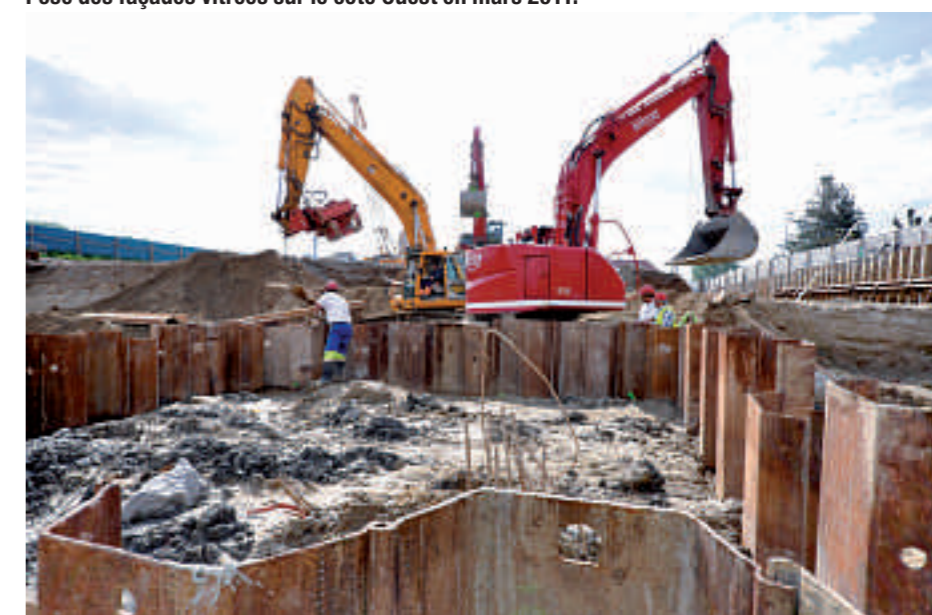
Gros-œuvre, fers, béton, palplanches en juin 2010.
