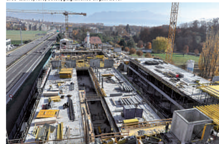
Vue Est-Ouest du chantier, sous la cabine des grues en novembre 2010.
