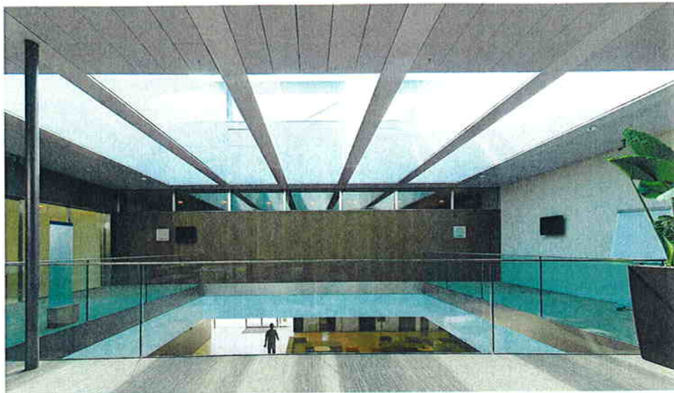
Le bâtiment de l'IMD - Maersk Mc-Kinney Møller Center à Lausanne est l'une des prestigieuses références de l'entreprise. Son concept statique original a été récompensé par le Prix Acier 2009.
